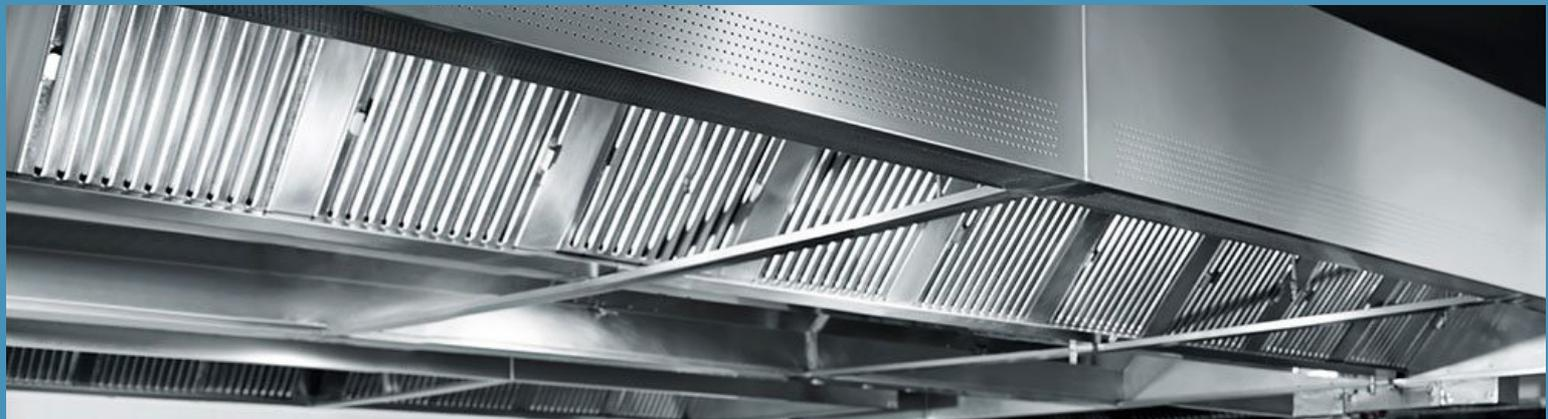
La acumulación gradual de la grasa y carbonilla, es el combustible idóneo para que se de el desagradable resultado de un incendio, que se podría haber evitado efectuando un preventivo mantenimiento y una limpieza periódica. Dependiendo de un menor o mayor funcionamiento de una cocina, ésta se ensuciará de manera exponencial y necesitará una mayor frecuencia de limpieza y desengrase.
